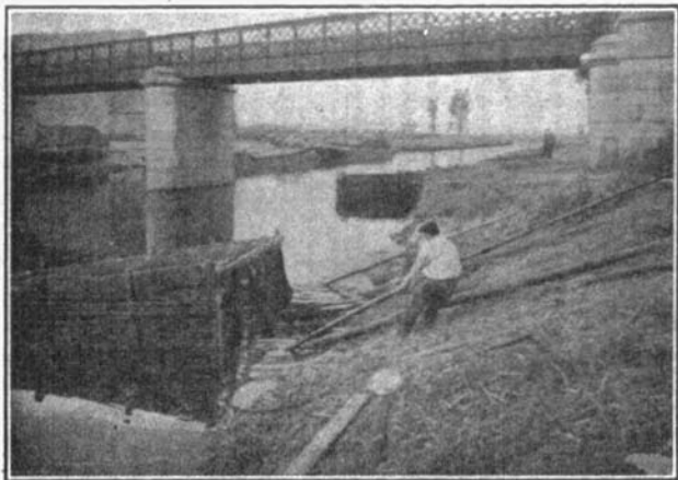
Inmersión de un cajón en el río.
