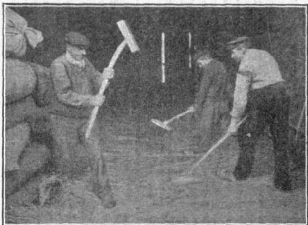
El lino se golpeaba a brazo para separar la materia incrustante.
