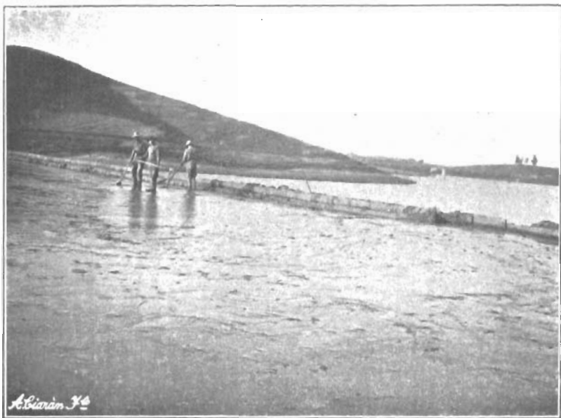
Presa de Silver Lake.—Distribución de los productos en el macizo en construcción.
