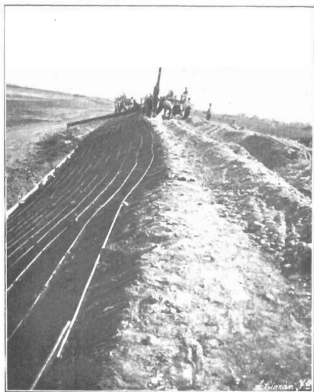
Revestimiento de hormigón armado de la presa de Terry Lake. Octubre de 1907.
