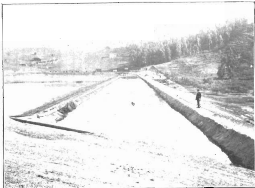
Presa de Silver Lake.—Vista superior del macizo en construcción. Noviembre de 1907.
