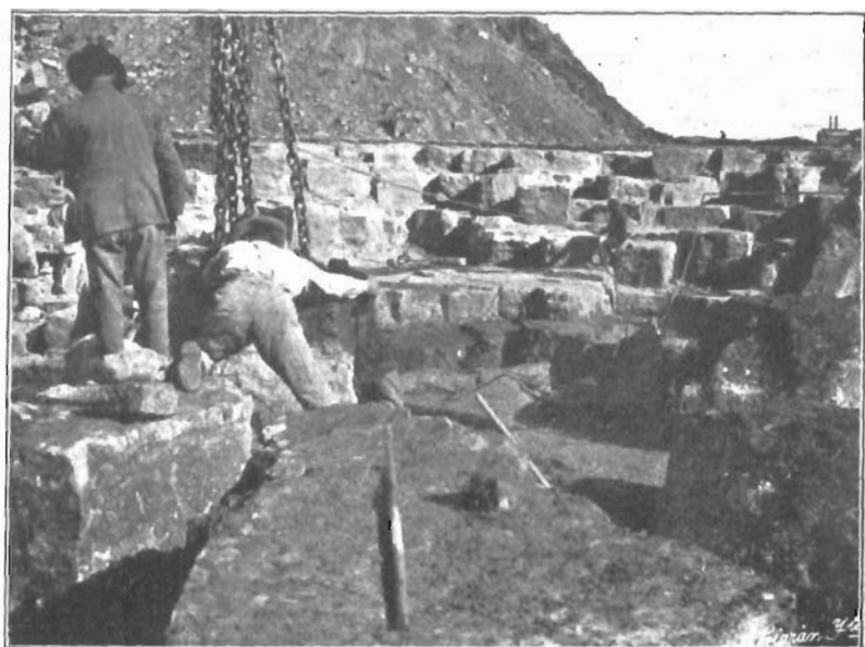
Ejecución de la mampostería de la presa de Roosevelt.
