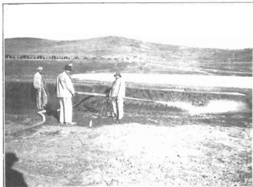
Presa de Silver Lake.—Desagregación del terreno por medio de monitores.
