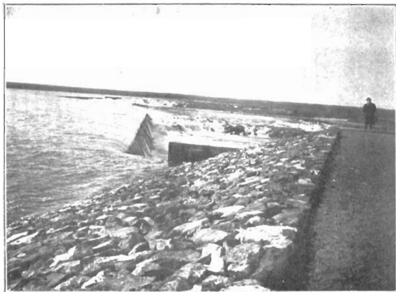
Presa de Minidoka.—Talud interior y vertedero. Noviembre de 1907.
