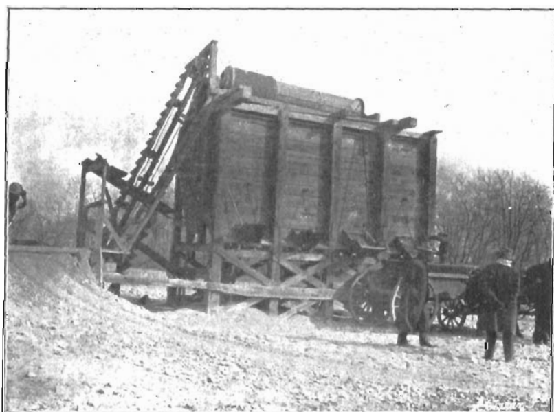
Cilindro clasificador y depósito de piedra y arena.
