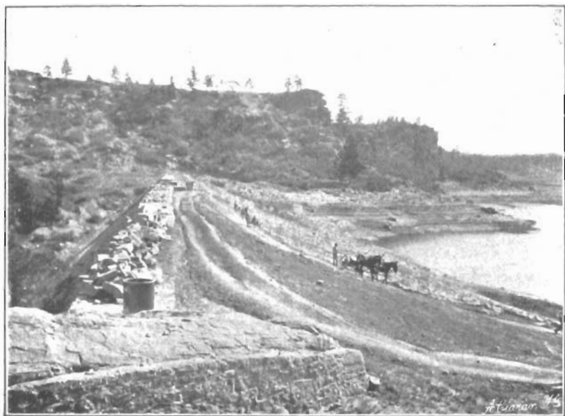
Presa de Castlewood.—Reparación del revestimiento de piedra. Octubre de 1907.
