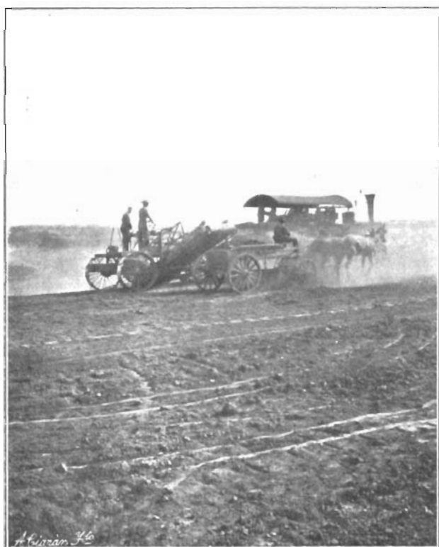
Presa de Belle Fourche.—Excavación y carga de tierras con «grader».
