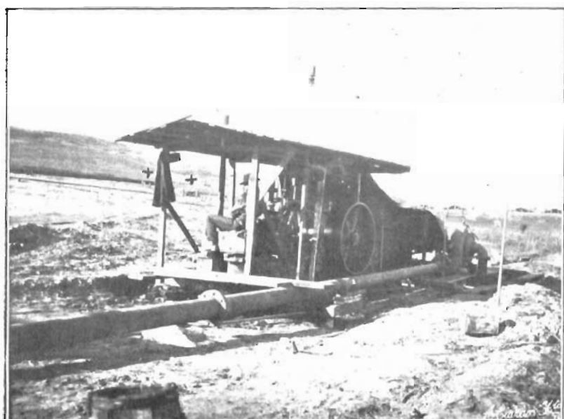
Presa de Silver Lake.—Elevación y transporte de los productos desagregados por medio de una bomba centrífuga.—(Las + indican los puntos en que se está desagregando el terreno.)
