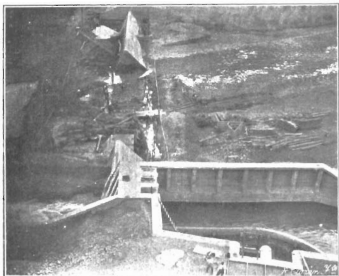
Presa de Corbett, en construcción.
