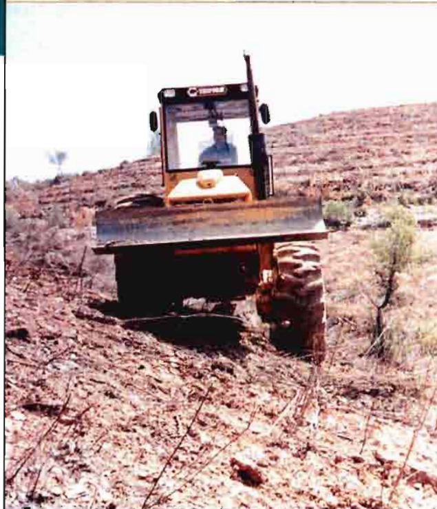
Los tractores TTAE preparan bien el terreno y evitan el realizar terraza.
