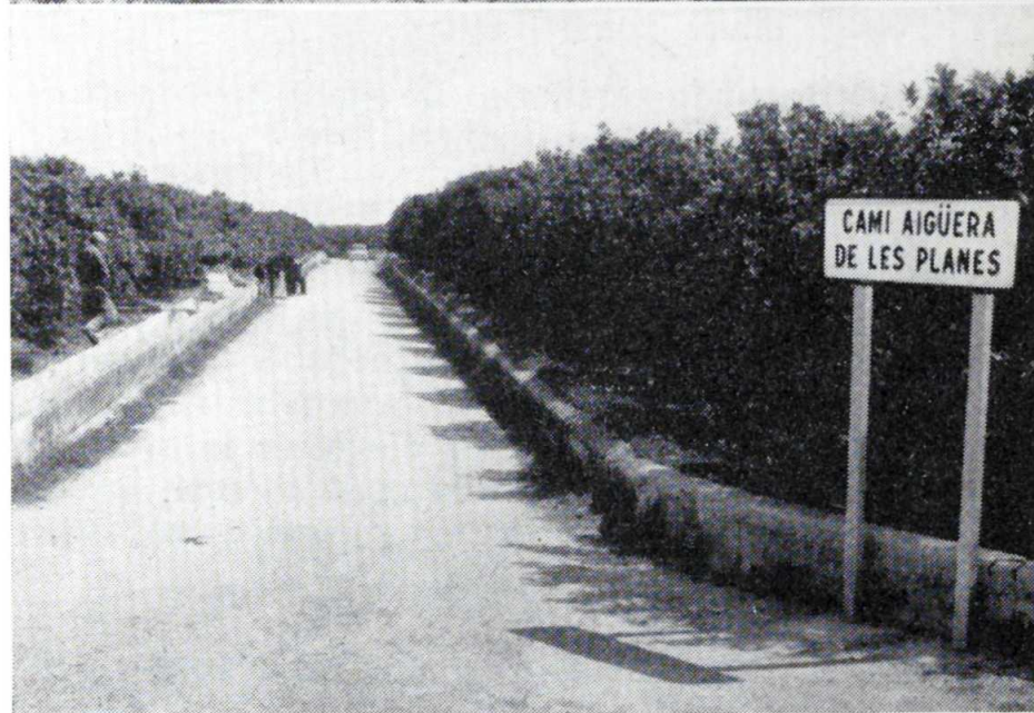
Una fase de la obra y el resultado.
