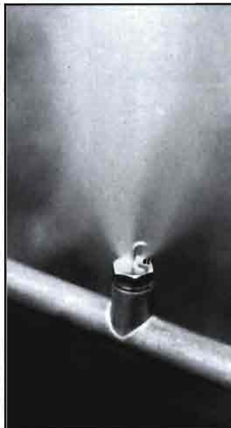
A la izq., curso de agua en Magic Mountain. Al lado, boquilla nebulizadora instalada en una tubería de cobre en un invernadero. Debajo, jardín enfriado con nebulización en una residencia del sur de California. Las boquillas están instaladas en una tubería flexible en las ramas de un roble.
