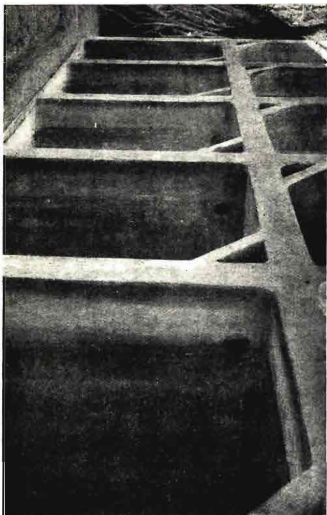
Detalle de los depósitos de la batería de difusión de la Estación de Viticultura y Enología de Requena (Valencia).
