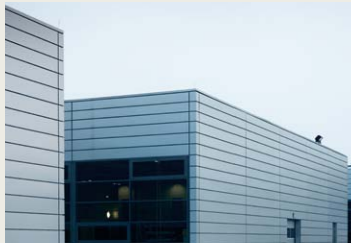
The module park in Iserlohn // Parco modulare a Iserlohn // El parque modular en Iserlohn
