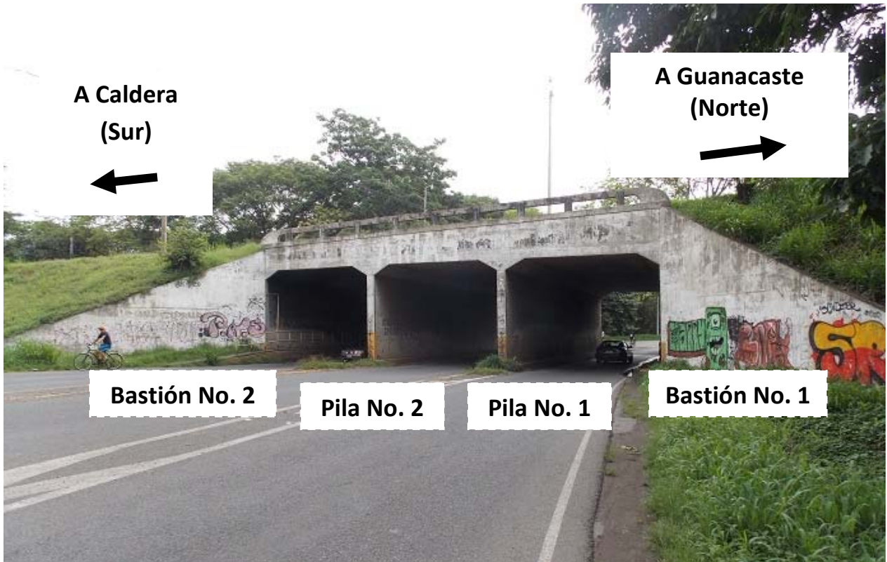
Figura D: Identificación utilizada. La foto muestra el costado este del paso a desnivel
