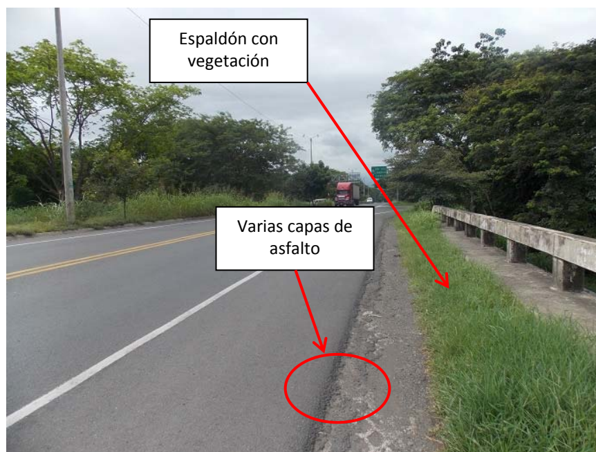
Figura 4: Superficie de rodamiento compuesta de varias capas de asfalto. El espaldón tiene vegetación.
