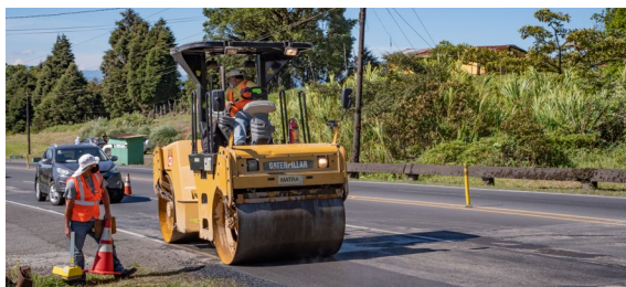
Figura 18. Compactación de bache.
