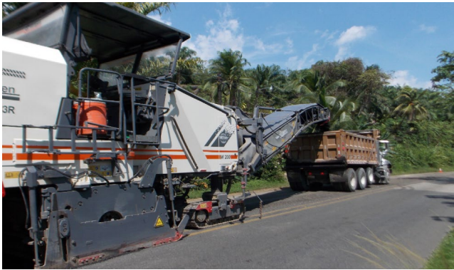
Figura 10. Escarificado de capa existente.
