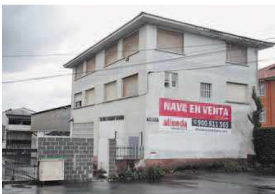
TALLERES CACHAZA (LEIXA) 781.900 euros. Conjunto de cuatro naves, dos «alpendres» y un edificio de oficinas, además de depósito de gas y una vivienda en ruinas.
