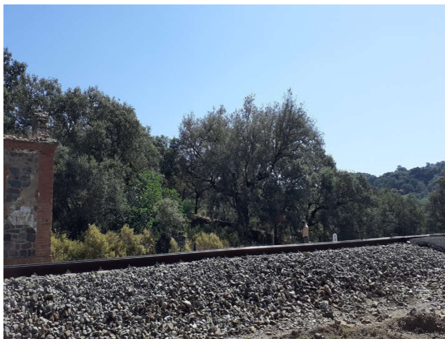
Foto18: Tomada en el P18 de las Operaciones Materiales (PS8) , en el cruce de la vereda y ferrocarril, junto a una casilla en ruinas.
