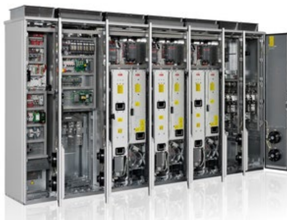
Figura 10. Ejemplo de un inversor central
