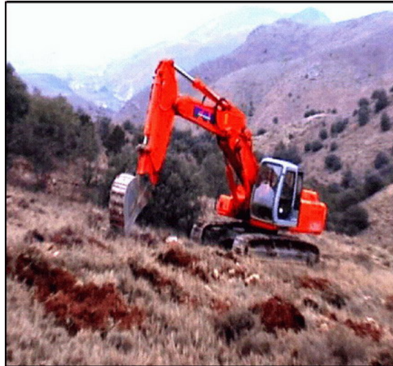
Figura 10: La fotografía muestra ejemplos de apertura de hoyos con retroexcavadora (Fuente: Rafael M a Navarro Cerrillo Departamento de Ingeniería Forestal-UCO)
