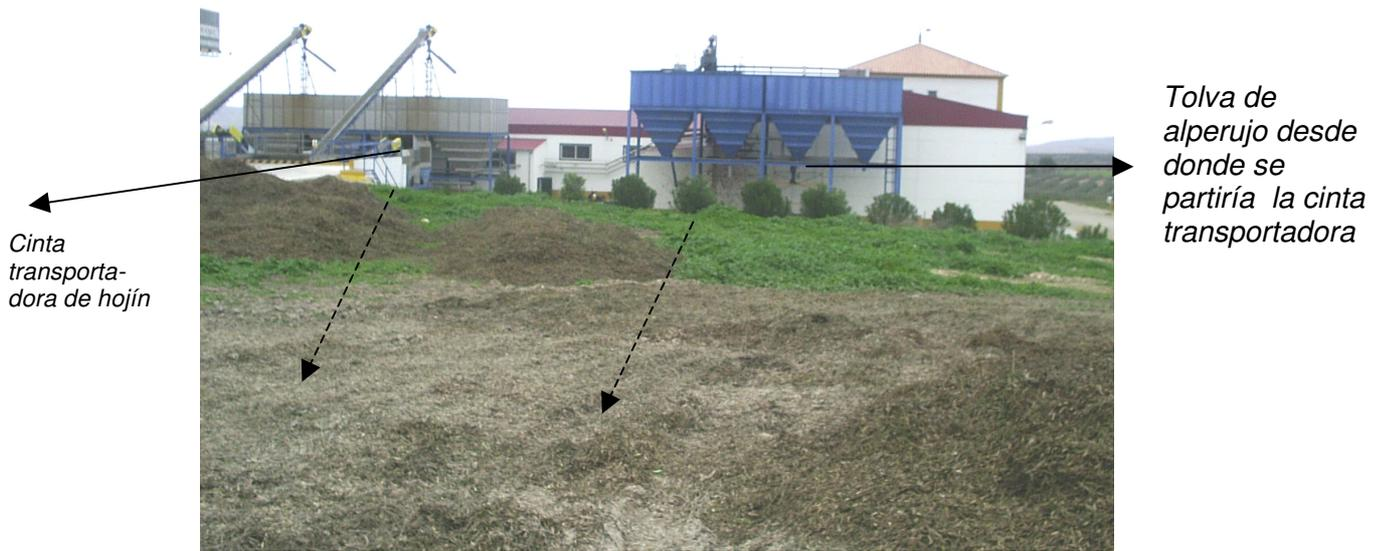
*Disposición relativa de la almazara y la explanación para la planta de compostaje*
