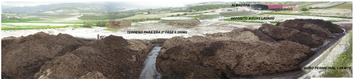
En la primera fase han construido una era de 3.000 m<sup>2</sup> sobre solera de hormigón con muro perimetral de 1,80 m de altura. La era tiene el 3 % de pendiente para recogida de lixiviados por gravedad. Se derivan los mismos a través de una tubería enterrada hasta un deposito de trasiego de 10 m<sup>3</sup> del que se bombea al deposito circular de aguas de lavado situado junto a la almazara.
