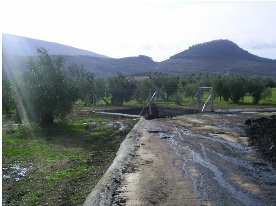
*Recogida por gravedad de los lixiviados hacia el depósito*
