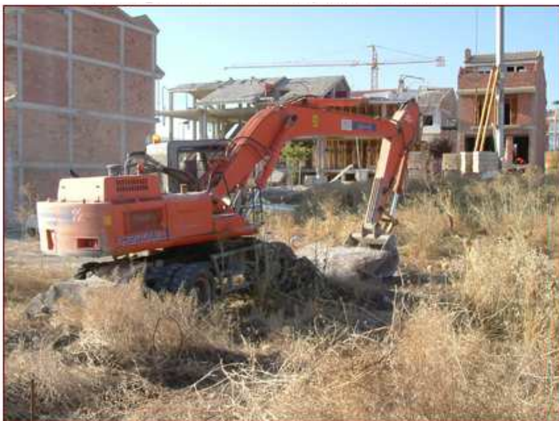
Lámina I.- Vista general del estado previo del solar.
