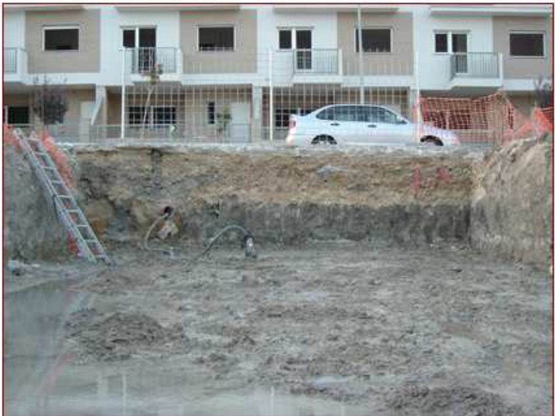
Lámina III.- Vista general del solar tras alcanzar el nivel freático.
