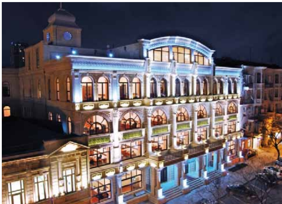
El nuevo edificio del Tribunal de Cuentas de la República de Azerbaiyán
