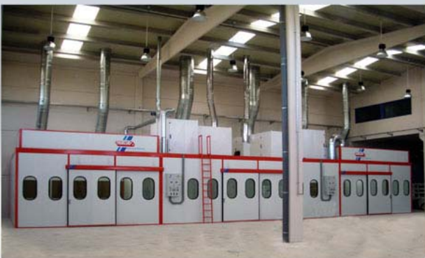
Instalación de pintura para acabado de alta calidad
