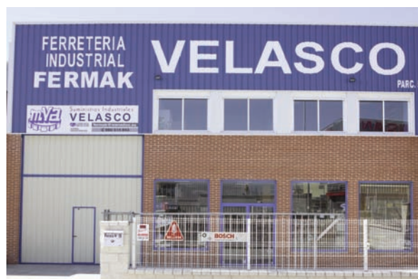
Instalaciones de FermaK 2000 en Zamora.
