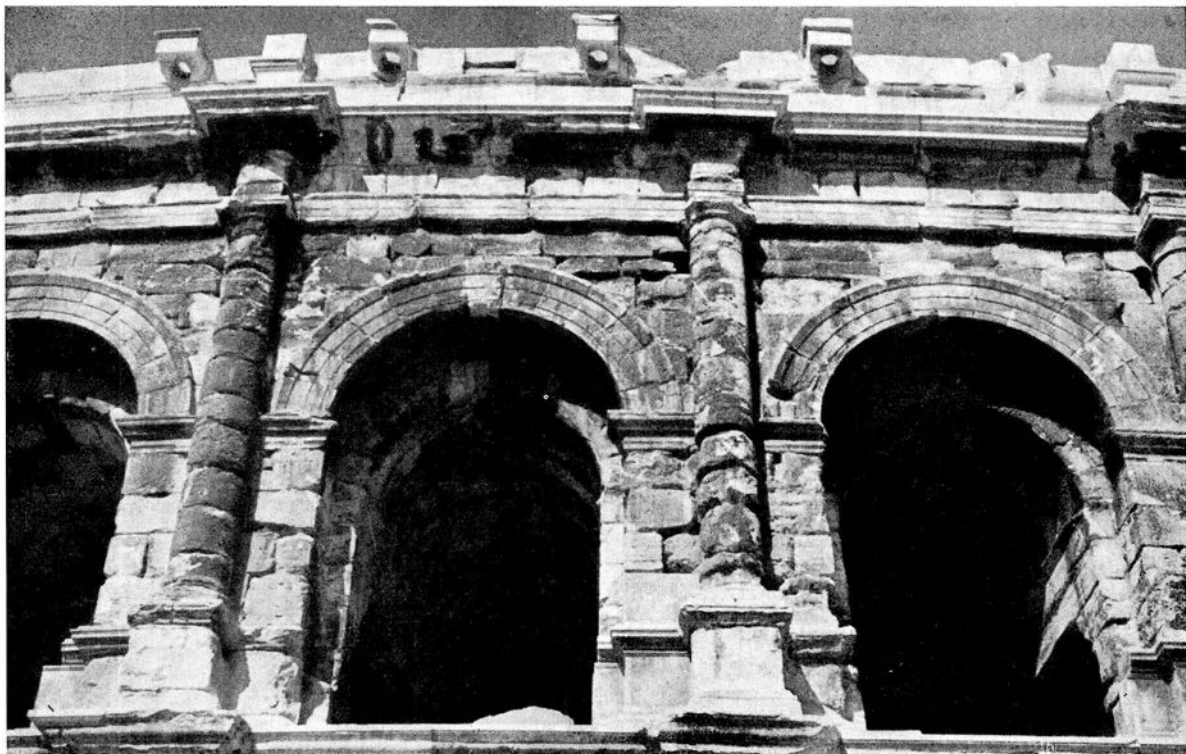
FIG. 29 - NÎMES, ANFITEATRO - Particolare dell'esterno dell'attico, con fori per i « mali » del velario.
