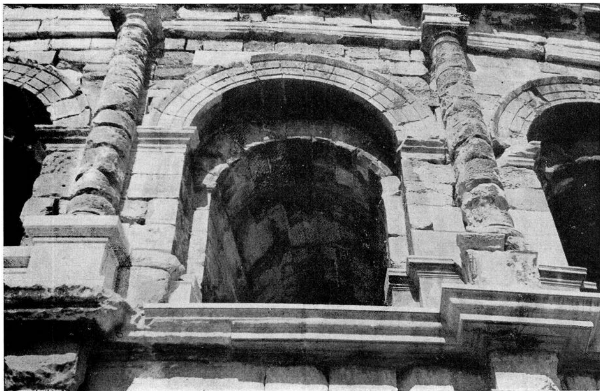
FIG. 17 - NÎMES, ANFITEATRO - Particolare dei fornicetti esterni del secondo ordine.
