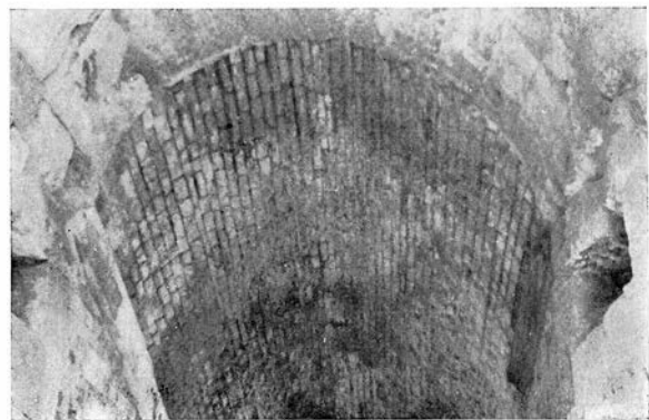
FIG. 3 - NÎMES, ANFITEATRO - Particolare della volta di un vano sostruttivo della cavea.
