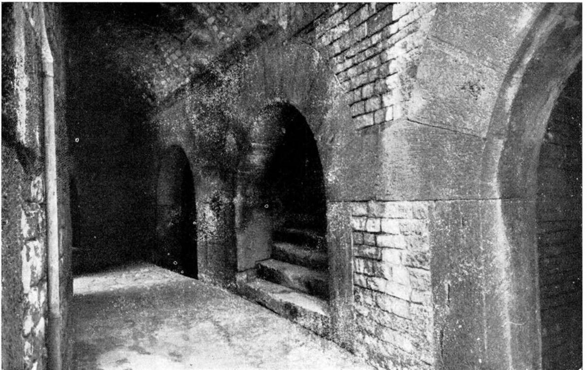
FIG. 22 - ARLES, ANFITEATRO - Particolare di un corridoio sostruttivo della cavea.
