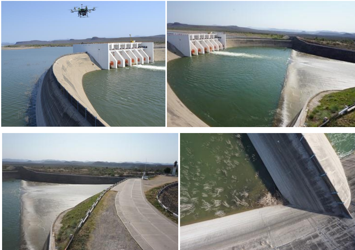
Figura 5.47 Presa Miguel Hidalgo
