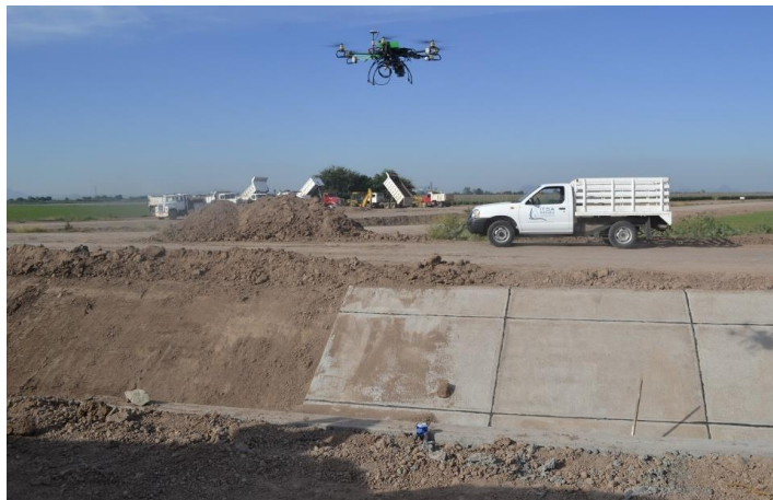
Figura 5.31 Supervisión de la construcción de una canal apoyada con drones en una zona de en el norte de Sinaloa, México
