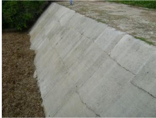
Figura 5.40 Características de las paredes del vertedor de la presa Los Sabinos
