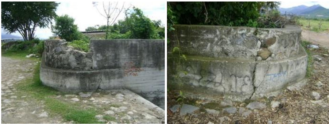
Figura 5.41 Detalle del paramento del vertedero
