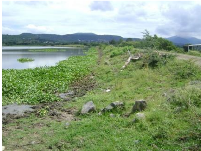
Figura 5.37 Detalle del talud aguas arriba de la presa Los Sabinos
