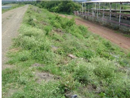
Figura 5.38 Aspecto del talud aguas debajo de la cortina de la presa Los Sabinos
