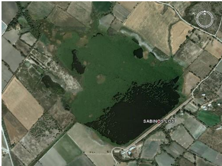
Figura 5.35 Inspección técnica a la presa de almacenamiento “Los Sabinos”, localizada sobre el arroyo Los Sabinos, en el municipio de Chapala, Jalisco. Fuente: Google Earth
