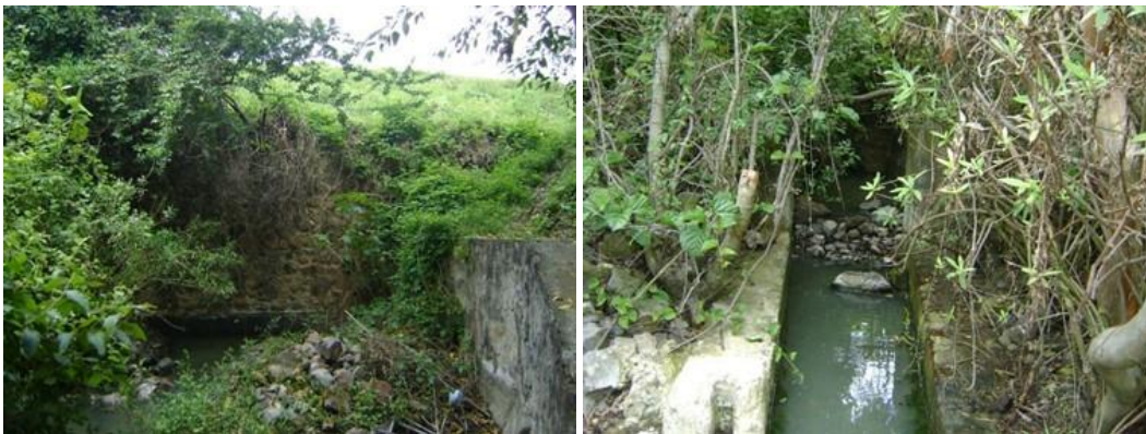
Figura 5.45 Detalle de la salida de la obra de toma
