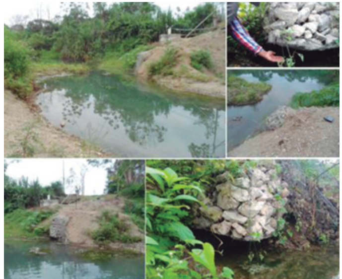
Figura 9. Falla de un tape artesanal durante la época invernal, visto desde diferentes puntos.
