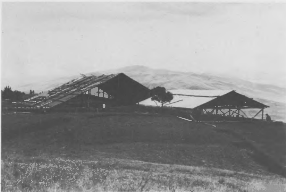
Figure 6. Equateur. Cochasqui. Structure de protection en matériaux appropriés au sommet d'une pyramide en 'cangahua'. Photo: auteur.
