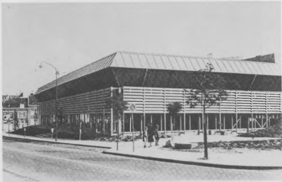
Figure 8. Hollande. Heerlen. Le musée des Thermes recouvert par une charpente tridimensionnelle de toiture. (Revue Acier, 1/80 avec permission).
