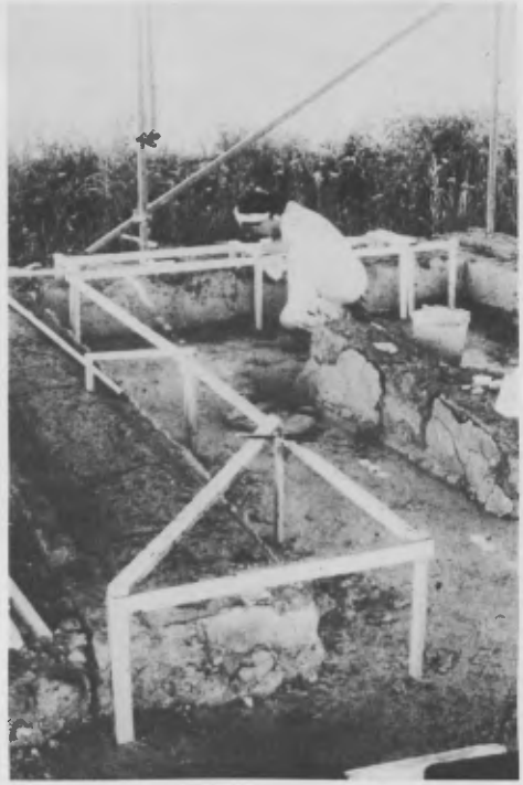
Figures 5-6: CIVITA MUSARNA (Viterbo, Italie), Calidarium; fixage préventif des fresques et protection in situ des parois en tuf avec argile expansée Leca.
