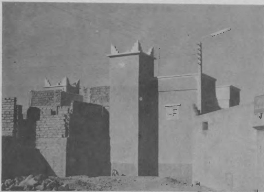
Architecture récente près de Ouarzazate.
