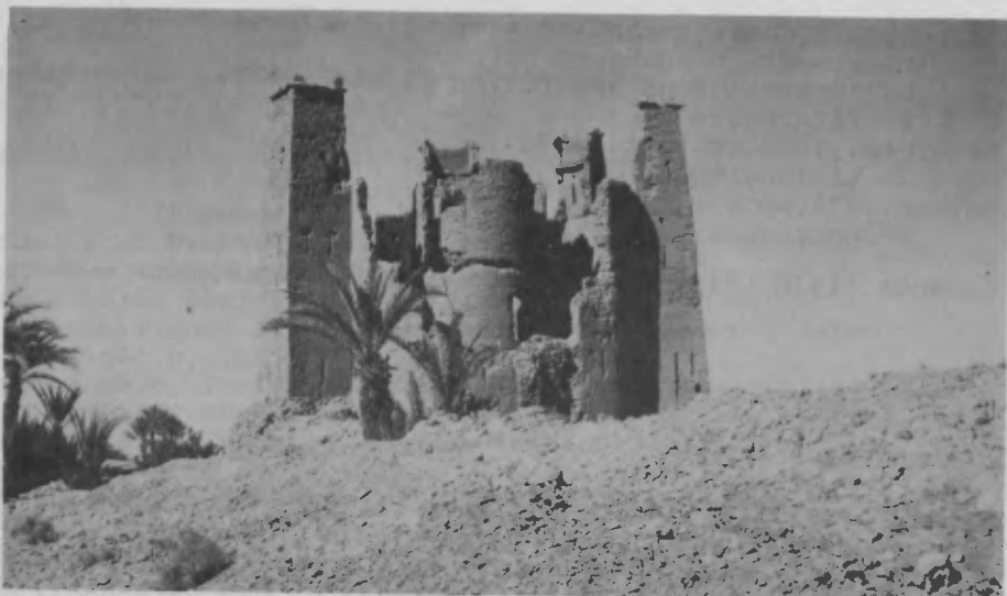
Vallée du Drâa: les architectures abandonnées se dégradent rapidement.
