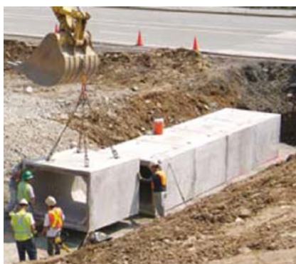
Figura 1.5 Sistema de alcantarillas de cuadro
