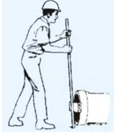
Figura 1.36 Instalación de tuberías de diámetros menores
