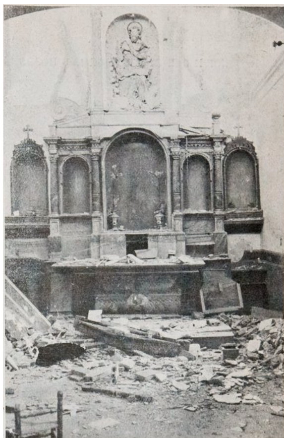
Figura 8.7. Interior de la capilla del hospital de San Mateo en 1936, tras cesar los combates
