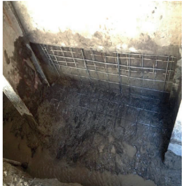
Fig. 10 Contención secundaria formada de concreto colado y malla electrosoldada. Proyecto Viaducto 52, colonia Atenor Salas, CdMx
