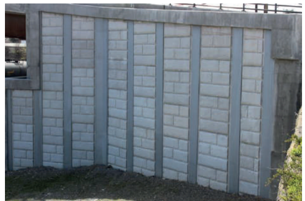
Fig. 27 Muro Berlín permanente con elementos de concreto prefabricado como tablonces (Eastern Vault, 2020)
