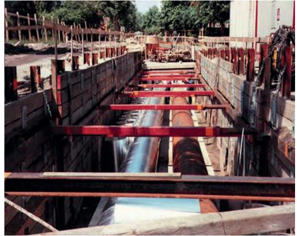
Fig. 9 Ademado de una excavación para una línea de conducción (Yepes Piqueras, 2015).
