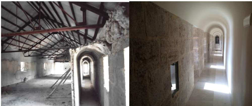
Fig. 12-Corredor de planta segunda que da acceso a las ventanas y saeteras de las fachadas, antes y después de la intervención.
