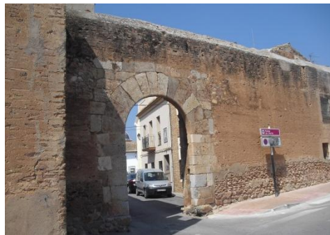
Fig. 2- Vistas de la puerta de l'Horta. La primera enmarcada en el bar del pueblo, de autor y fecha desconocidos. La segunda de su estado actual.
