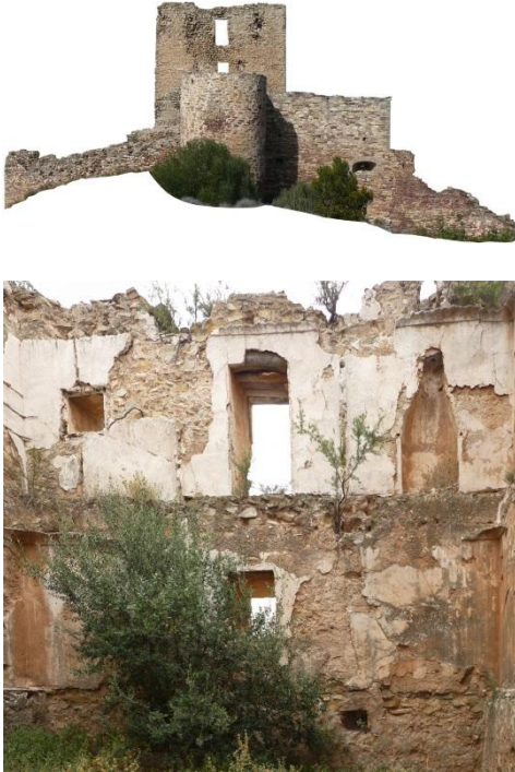
Fig. 1- Exterior e interior de la torre del castillo de Torres Torres situado en el valle del río Palancia
