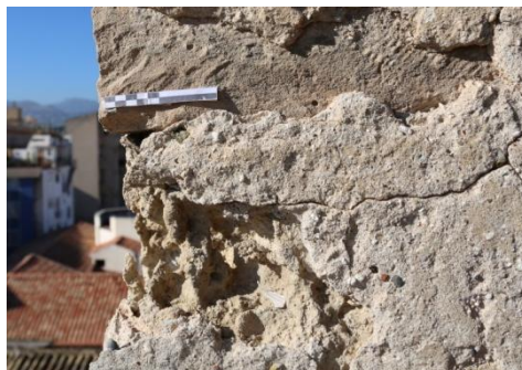
Fig. 6 - Grave alveolizzazione di uno spigolo.
