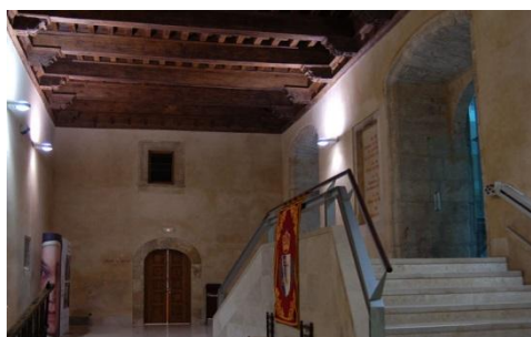
Fig. 3- Zaguán de entrada antes y después de la intervención. (James Manson, 2005).
