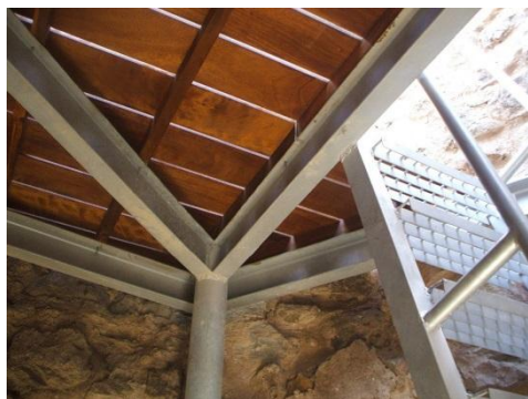
Fig. 7.- Detalle del interior de la Torre con la solución de la cubierta. (P.E. Collado)
