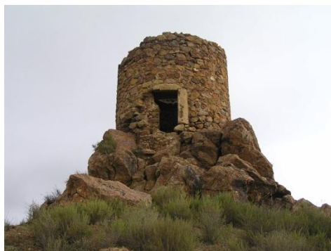
Fig. 4.- Imagen general de la Torre del Molinete antes de la restauración. (P.E. Collado)
