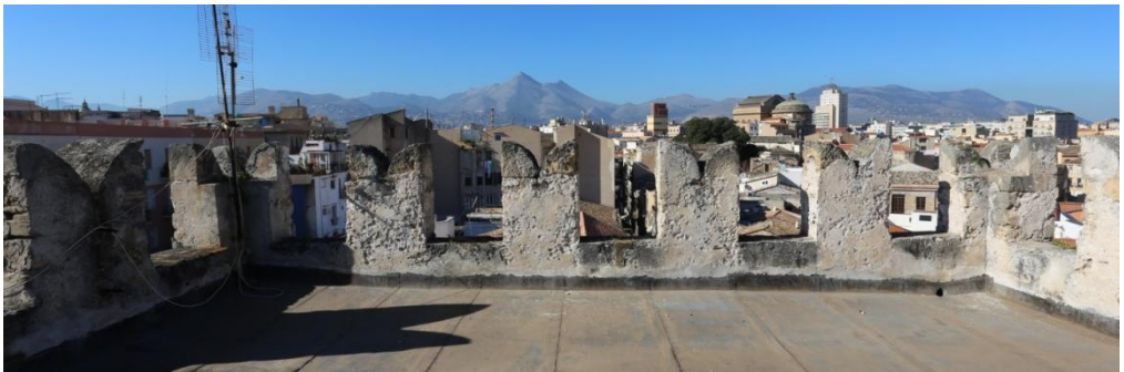
Fig. 4 - Il piano di copertura della torre e i merli.
