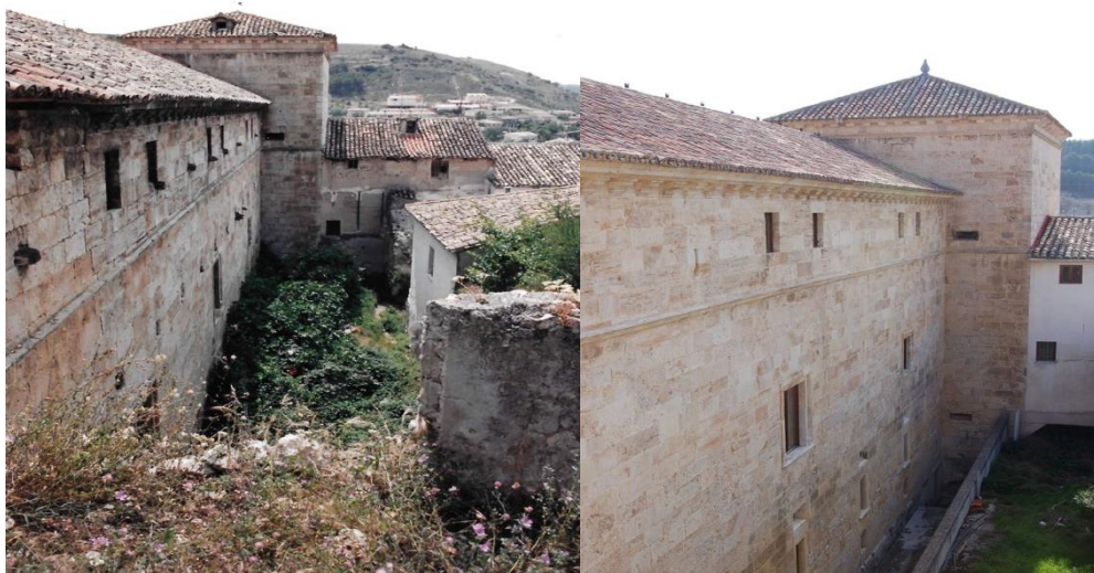
Fig. 11- Alzado oeste, antes y después de la intervención.
