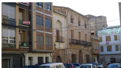
Fig. 1.- El palacio antes de la intervención
