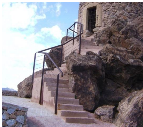
Fig. 5.- Detalle de la nueva escalera de hormigón coloreado y barandilla metálica para acceso a la Torre. (P.E. Collado)
