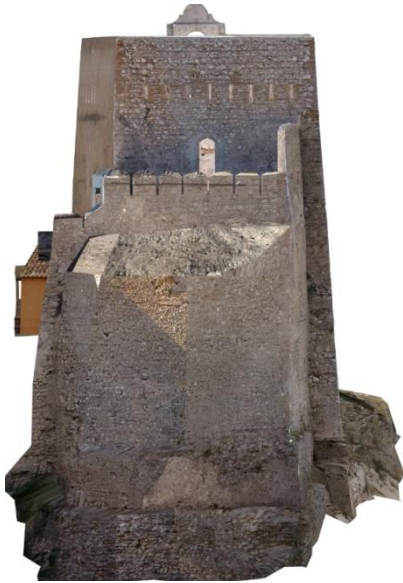
Fig. 3- Ortofotografía del Baluarte de defensa del acceso a la Torre Mayor (Global Mediterranea)
