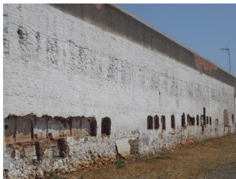
Fig.6.- Vista del lienzo sur de la muralla, donde estuvo adosado el cementerio de Mascarell.
