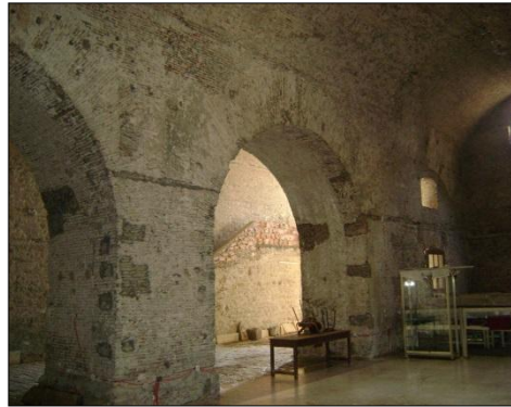
Fig. 9- vue sur la grande salle après le décapage des crépissages (Korichi, Amina, 2011)
