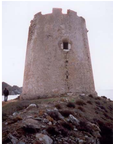
Fig. 1- Torre di Piscinni
