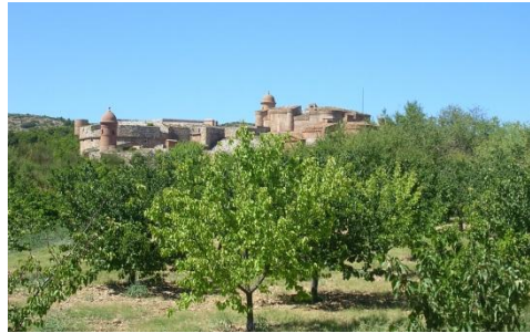
Fig. 2- Vista panorámica de la fortaleza
