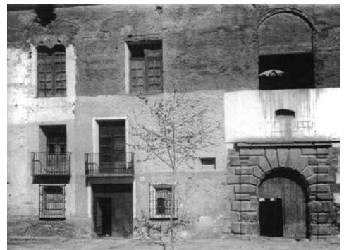
Fig. 6.- Fachada del palacio de Betxí antes de su derribo parcial en 1969.
