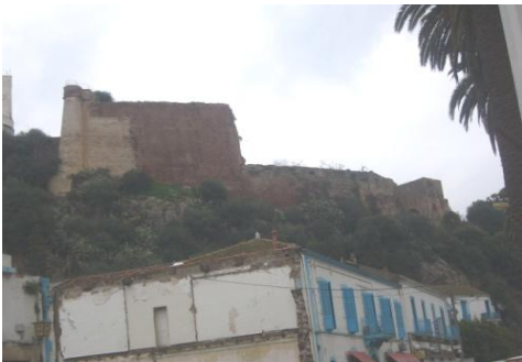
Fig.1-vue sur la casbah de Bejaia (Korichi.Amina 2010)
