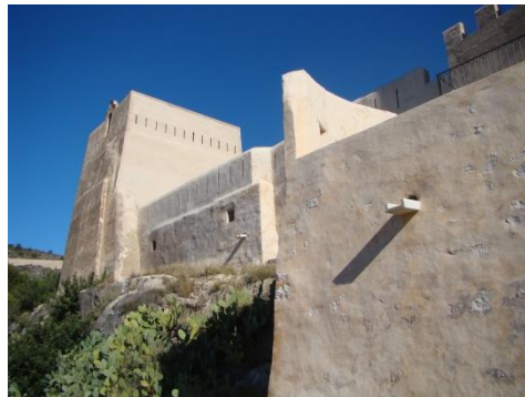
Fig. 5- Fachada occidental de la Fortaleza, en primer término los restos del Revellín del siglo XVI que defendía el acceso. Al fondo la Torre Major con el remate aspillerado del siglo XIX.
