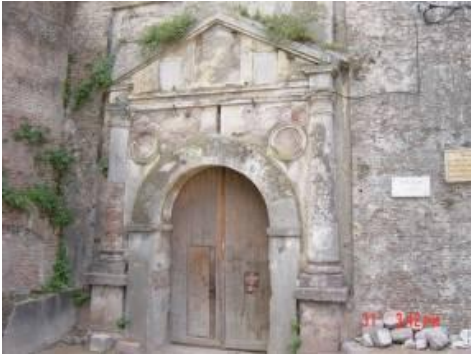
Fig. 4- vue sur la porte de la casbah (Korichi, Amina, 2010)
