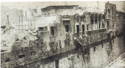
Fig. 8- Il palazzo con la loggia cinquecentesca durante le demolizioni, eseguite negli anni Venti del Novecento (La Duca, 1980).
