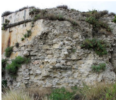
Fig. 4 - Dettaglio della sezione muraria della cortina-fronte 3.
