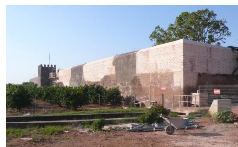
Fig.5.- Estado del muro previo a la restauración y tras las obras efectuadas en 2008.
