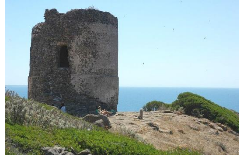
Fig. 12 –Torre di Foghe
