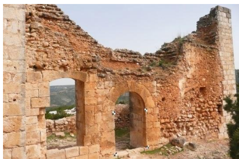
Fig. 4- Detalle de arcos y huecos recercados con sillería del siglo XV en el castillo de Chirel
