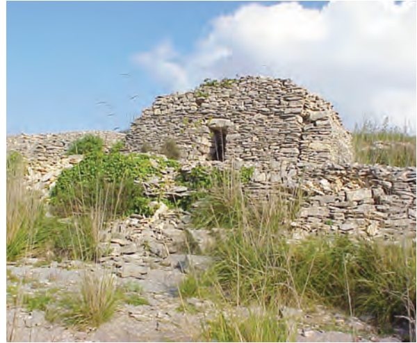
Figg. 106-107: Monte Bonifato, resti di costruzioni edificate con pietra locale “a secco”.
