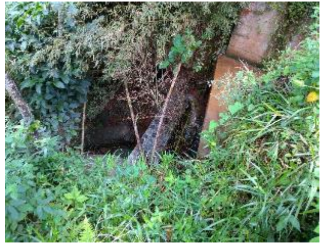
Foto 25 Aspecto general del descole de la alcantarilla Fuente: El Autor
