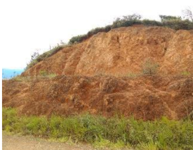
Foto 5 Aspecto general de un talud conformado por el suelo residual de la Formación Volcánica. Fuente: El Autor
