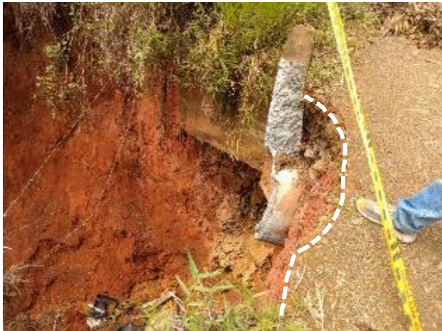
Foto 19 Aspecto general del descole de la alcantarilla Fuente: El Autor
