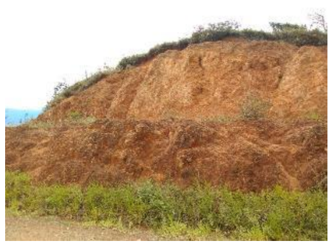
Foto 16 Corte vertical de ladera sobre los suelos residuales de la Formación Volcánica Fuente: El Autor
