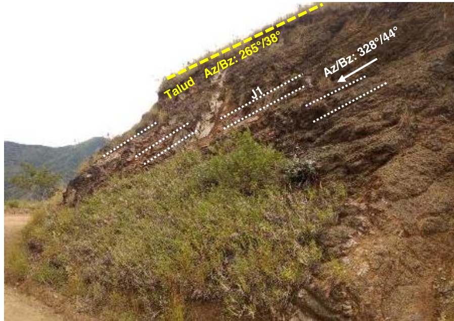
Foto 2 Aspecto general y toma de datos estructurales del afloramiento del macizo rocoso N°2, abscisa K4+700.
