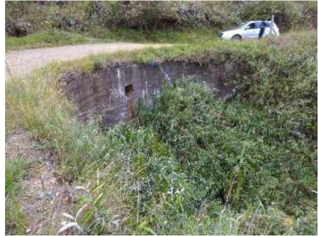
Foto 30 Aspecto general del descole de la alcantarilla Fuente: El Autor
