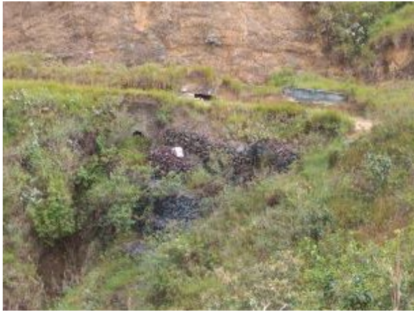
Foto 29 Aspecto de muro de contención flexible en gaviones. Fuente: El Autor
