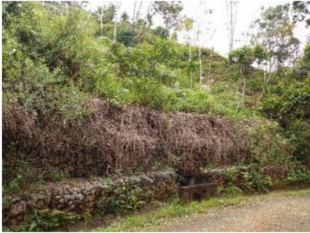
Foto 22 Obra de contención existente en el movimiento en masa N°2 Fuente: El Autor
