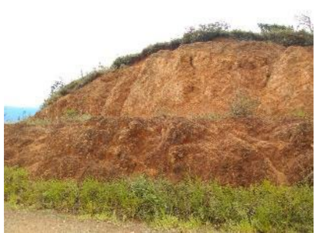
Foto 16 Corte vertical de ladera sobre los suelos residuales de la Formación Volcánica Fuente: El Autor
