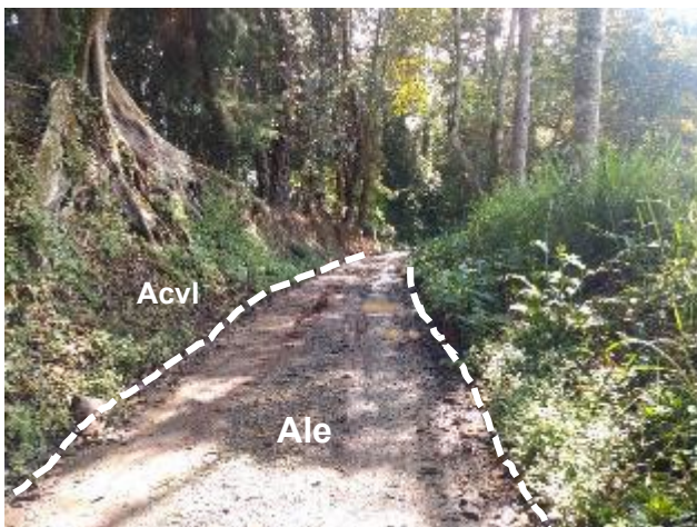
Foto 15 Corte vertical de ladera sobre los suelos transportados de planicie aluvial Fuente: El Autor
