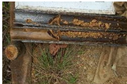
Foto 56 Roca blanda encontrada en las perforaciones realizadas para la Obra N°5 Fuente: El Autor
