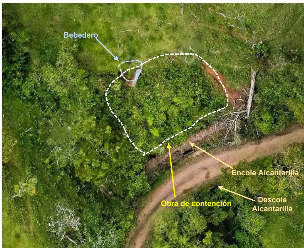
Ilustración 18 Aspecto general en planta del movimiento N°2- Fuente Imagen: Ortofotoimagen
