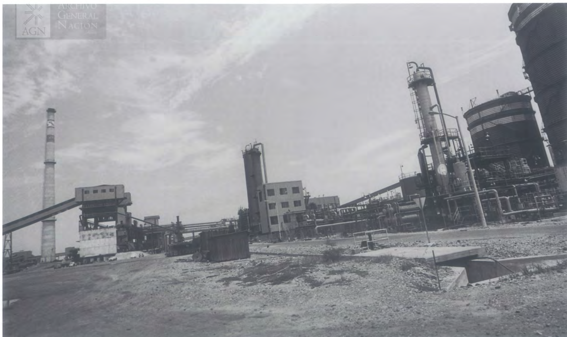
Siderúrgica Las Truchas, Lázaro Cárdenas, Michoacán, 1976.
