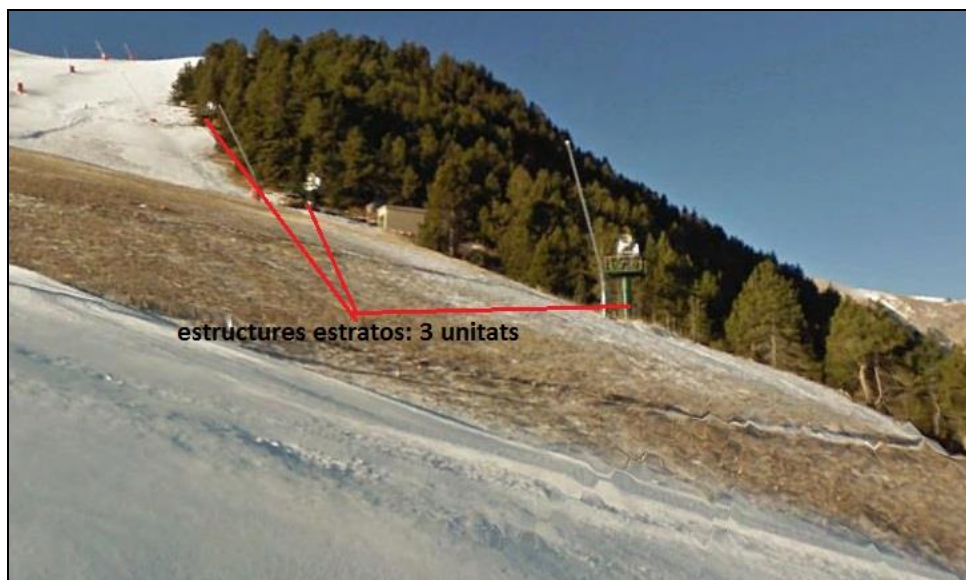
Vista de la pilones de suport del Stratus, aproximadament 4 Tones
