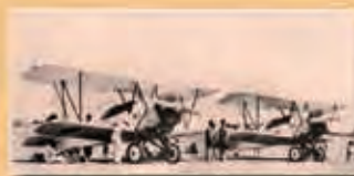
Aviones Travel Air Type 4000 , equipados con un motor Wright Whirlwind de 200 Hp. Guayaquil, diciembre de 1929.
