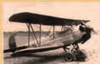
Año de 1935, Curtiss-Wright CW-16E Trainer . Motor radial de siete cilindros y 420 HP, estructura metálica revestida en tela con su cubierta delantera del fuselaje en aluminio. Fue el primer avión diseñado para entrenamiento básico y avanzado al servicio de nuestra aviación militar.
