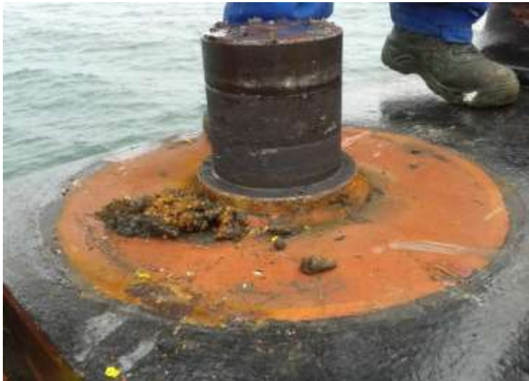
ROLETE EN MANTENCION, LIMPIO Y DESTAPADO LAS SALIDAS DE GRASA PARA UNA BUENA LUBRICACION AL TRABAJO DE LAS ESPIAS
