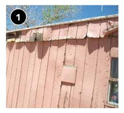
Asegure la integridad de la pared a aislar, tanto del exterior como del interior. Tenga en cuenta: Esta casa no es apta para el aislamiento de las paredes, ya que el exterior no evita que entre agua y los daños del revestimiento necesitan reparaciones mayores.
