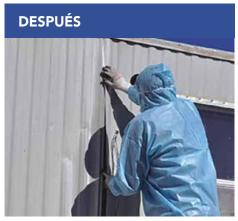
Cuando se aísla correctamente, el entablado no debe abultarse ni abollarse como resultado de la instalación. Documente la ubicación de cualquier abolladura preexistente y señálela al propietario del edificio antes de comenzar un proyecto.
