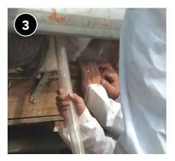
Rellene la cavidad con aislamiento de fibra de vidrio soplado; maniobre con cuidado el tubo de llenado más allá del riel para cinta y alrededor de la caja/ cableado eléctrico.
