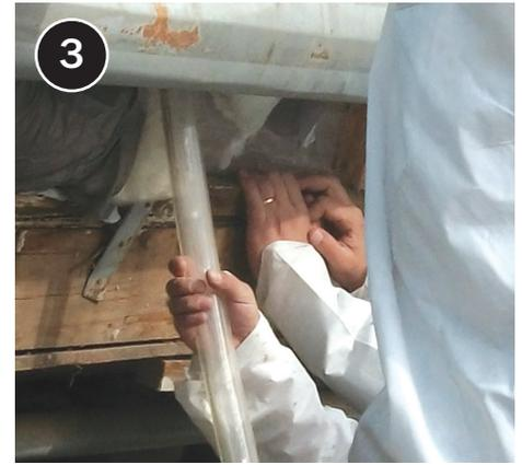
3 Rellene la cavidad con aislamiento de fibra de vidrio soplado; maniobre con cuidado el tubo de llenado más allá del riel para cinta y alrededor de la caja/cableado eléctrico.
