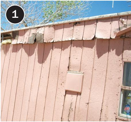
1 Asegure la integridad de la pared a aislar, tanto del exterior como del interior. Tenga en cuenta: Esta casa no es apta para el aislamiento de las paredes, ya que el exterior no evita que entre agua y los daños del revestimiento necesitan reparaciones mayores.
