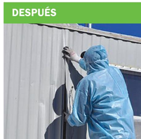
DESPUÉS Cuando se aísla correctamente, el entablado no debe abultarse ni abollarse como resultado de la instalación. Documente la ubicación de cualquier abolladura preexistente y señálela al propietario del edificio antes de comenzar un proyecto.
