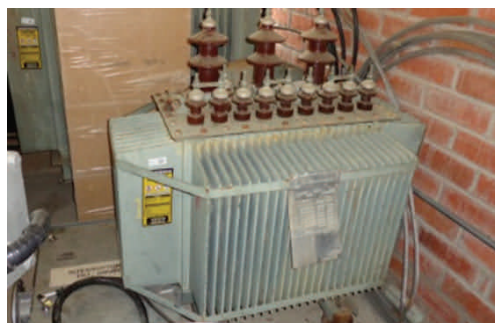
Foto 1.- Transformador que contiene PCB's –bodega Saucay
