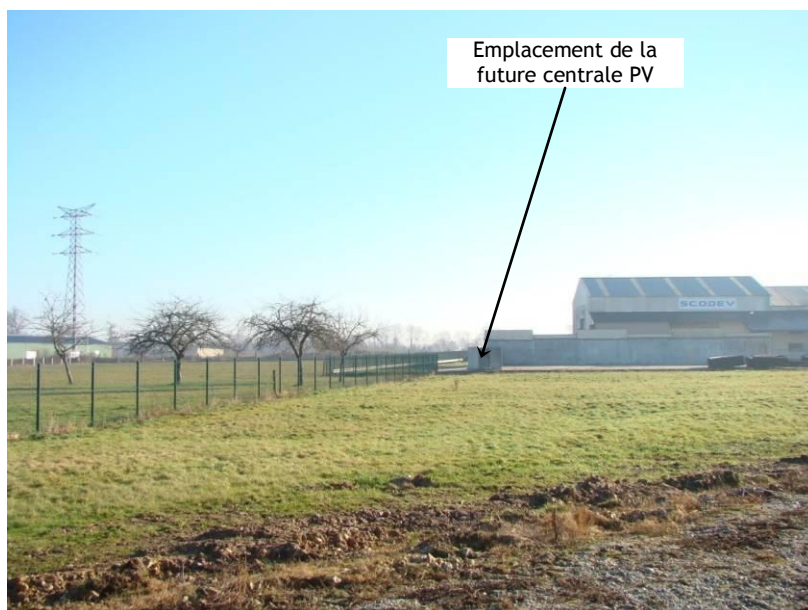
Photo 12 : Vue depuis la voie d'accès aux bâtiments de la SCODEV
