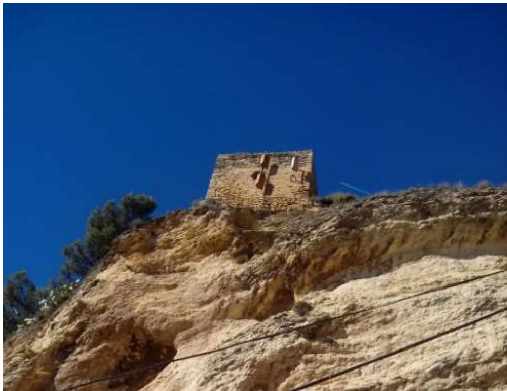
Fig. 10. Torre de la muralla de la alcazaba de Montefrío, que también sufrió el asedio y derribo de sus defensas por los cañones cristianos en la campaña de los Reyes Católicos de 1486. Fotografía: Francisco Vidal-Castro.
