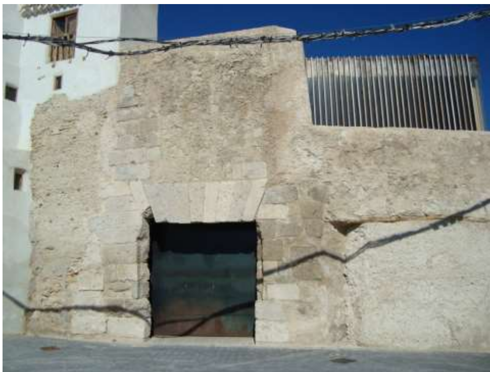
Fig. 4. Puerta del Sol (actual Arco del Santo Cristo), restos de la muralla cerca de la alcazaba de la nueva Huéscar, fundada por Ismā'īl I en 1324 tras conquistar con artillería pirobalística la anterior fortaleza, situada en la cercana Sierra de la Encantada. Fotografía: Francisco Vidal-Castro.
