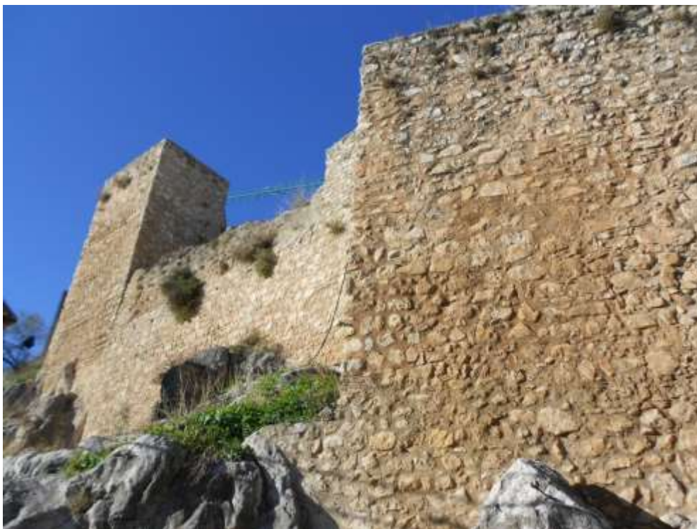
Fig. 9. Murallas del castillo de Íllora, que ante el bombardeo y destrucción de sus murallas por los cañones de los Reyes Católicos debió rendirse en 1486.
