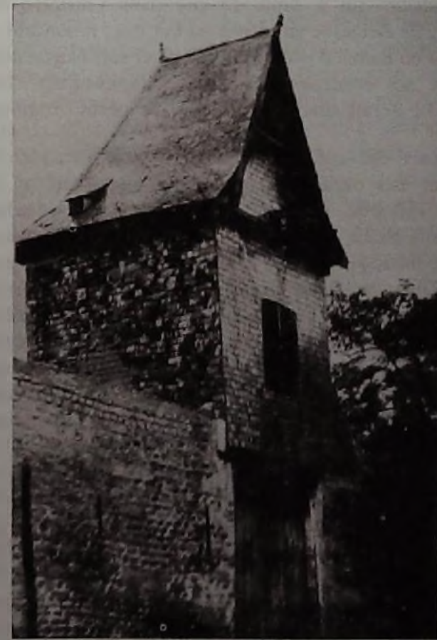
PEUTY. — La tour aux pigeons au-dessus de la porte d'entrée de la ferme.
