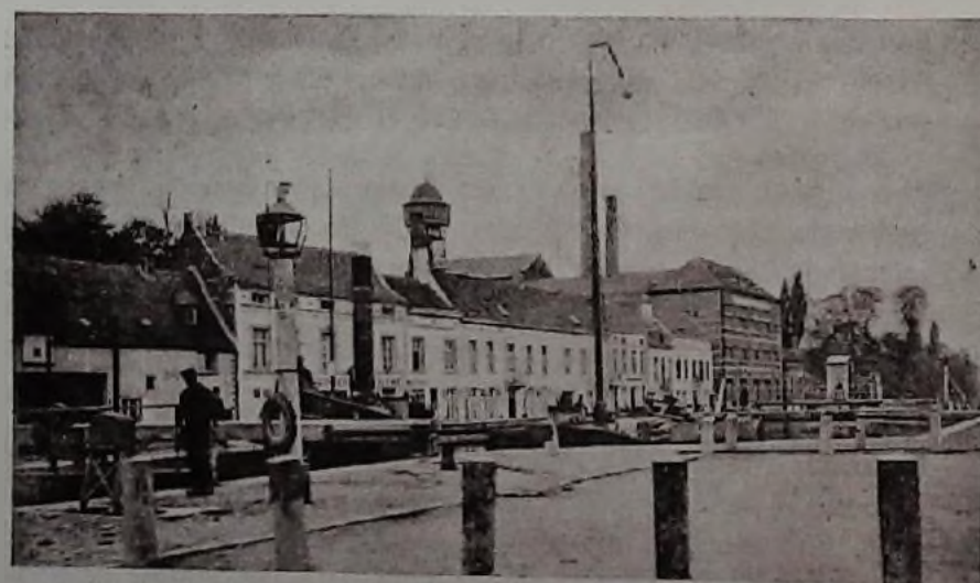
VILVORDE. — L'écluse du canal de Willebroeck.
