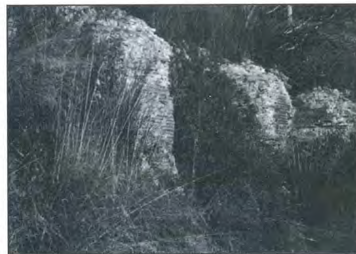
Fig. 17: Contrafforti in laterizio di un tratto di costeggiamento dell'acqua Claudia lungo la via di Pomata (Tivoli).
