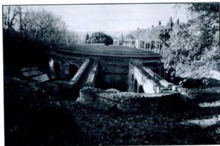
Fig. 51 Canali di adduzione dell'acqua sul fronte del Canopo
