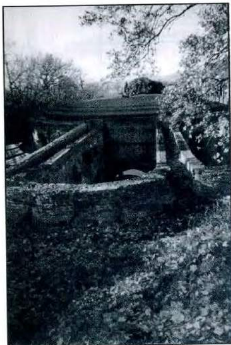
Fig. 49 I canali di adduzione dell'acqua al Canopo poggiano su strutture simili alle arcate di un acquedotto
