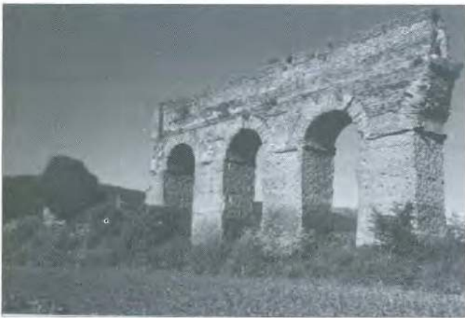
Fig. 13 Tratto dell'acquedotto Anio Novus, a monte di Tivoli.
