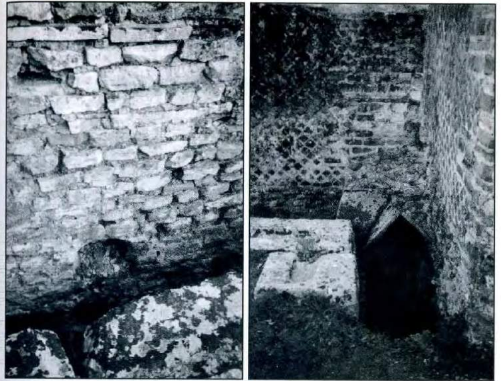
Fig. 56 Tubo di adduzione dell'acqua pulita nella latrina degli hospitalia (sx); Canale di smaltimento delle acque sporche nella latrina degli hospitalia (dx).
