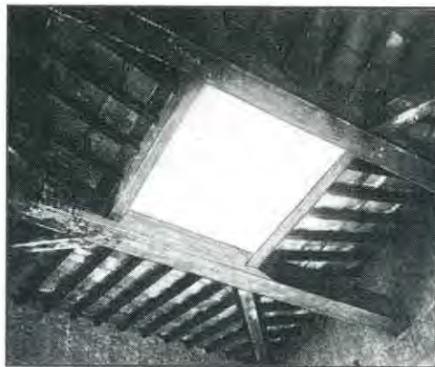
Fig. 8 . Compluvium . Ricostruzione della copertura dell'atrio di tipo tuscanico (Vitruvio)
