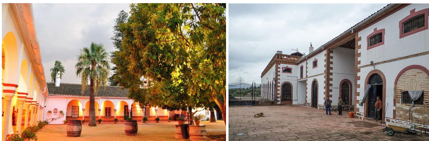
Buen estado de conservación de la Hacienda TORQUEMADA Sevilla. (Zona HACIENDAS DE SEVILLA Y CÁDIZ) y de la Casería del Corregidor (Zona MONTORO Y ENTORNO).
