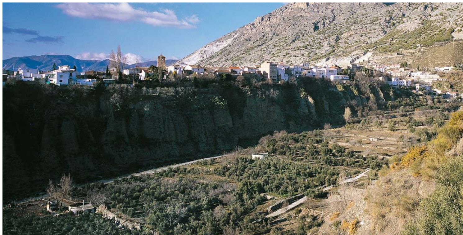
La almazara de La Erilla y bancales se sitúan en el borde urbano de Nigüelas , sobre la rambla del río Torrente.
