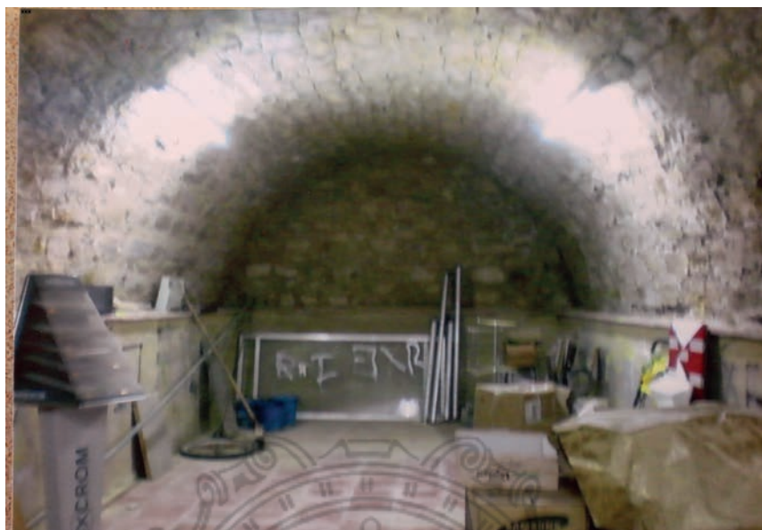
Bóveda de medio cañón que perteneció al convento.
