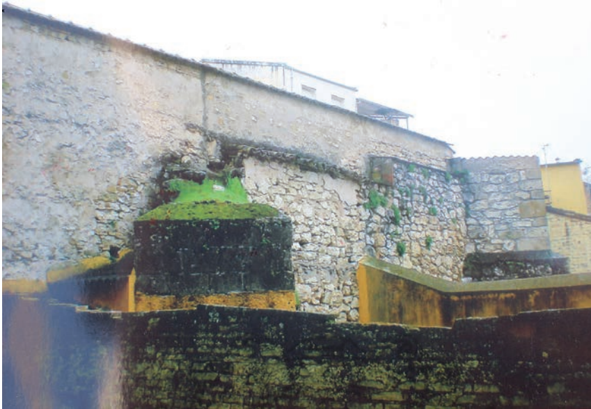
Resto de muro del convento.
