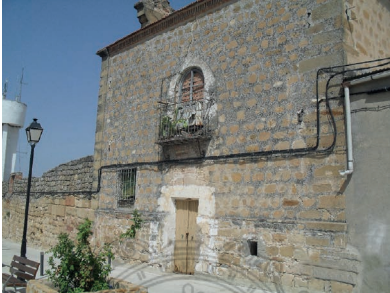
Fig. 2.–Vano de acceso posterior del edificio de la Carrera. Fuente: Juan Antonio Moral Campos.
