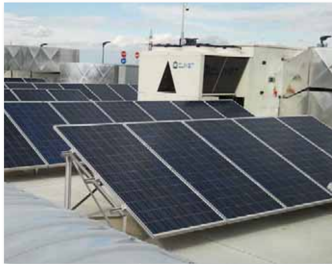
Triángulo a 30° con lastre.
