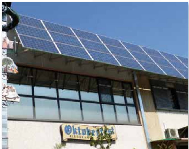
Estructura de techo inclinado.
