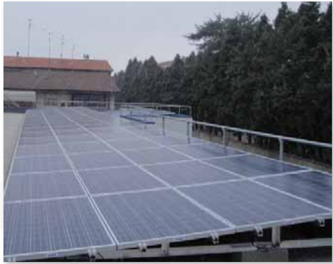
Triángulo largo con lastre.
