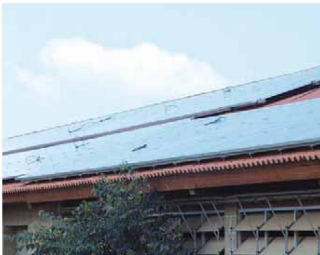
Techo inclinado - recuperación de amianto.
