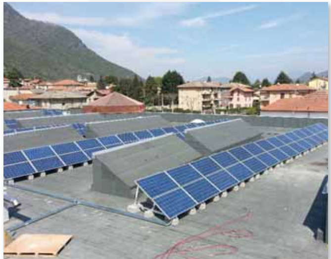
Triángulo doble horizontal a 30° y lastre.
