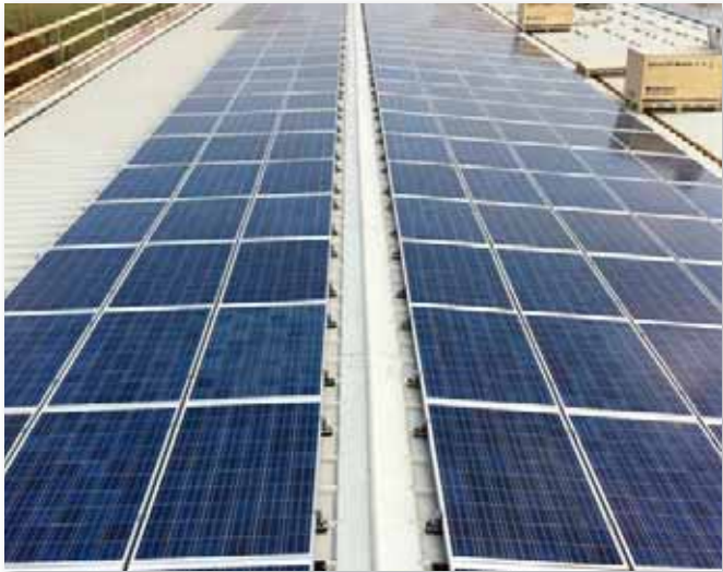
Techo de chapas acanaladas con FVT5000.
