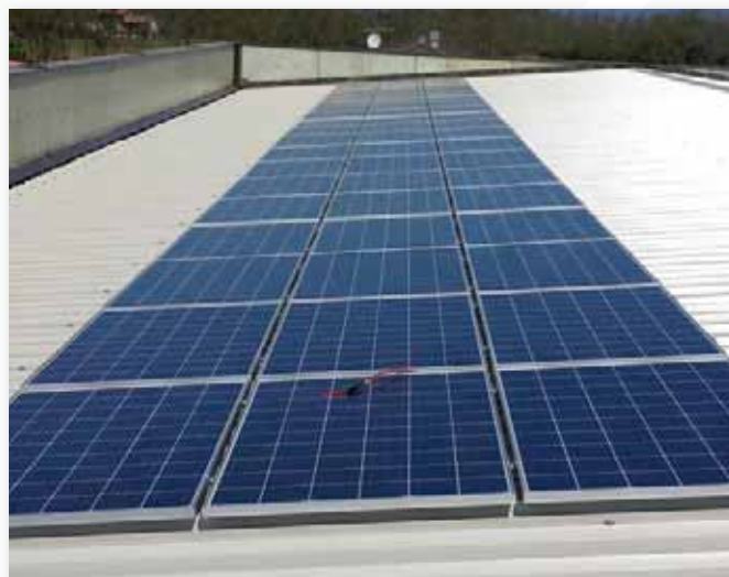
Cubierta metálica con FVT5000.
