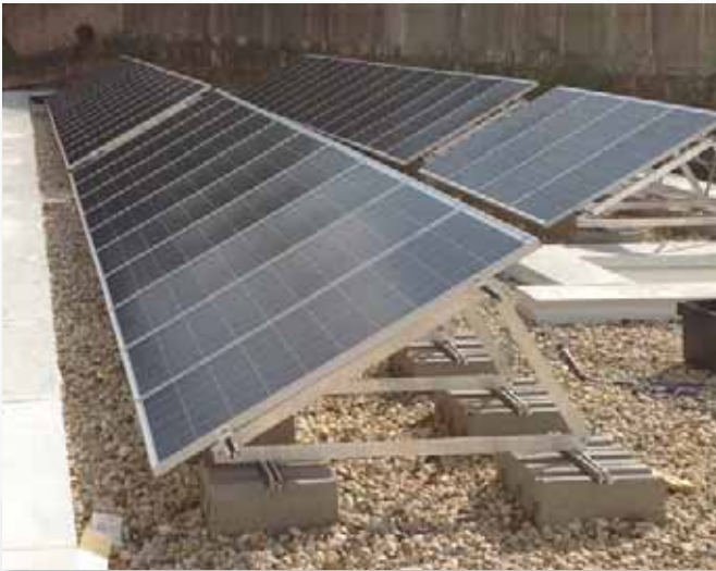
Triángulo simple vertical a 30°, lastrado.
