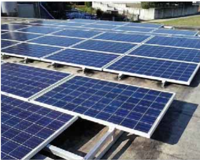
Triángulo triple horizontal, lastrado.
