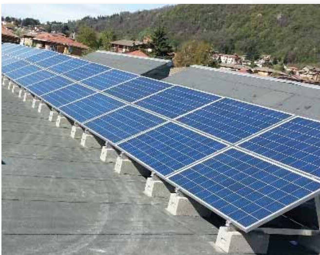
Triángulo doble horizontal a 30°, lastrado.
