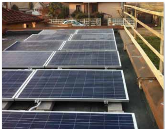
Lastre "FLAT" con paneles horizontales.
