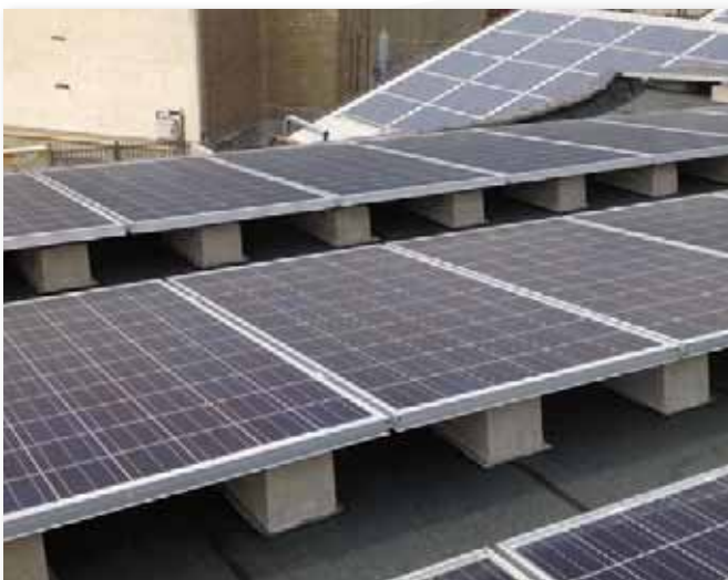
Lastre "FLAT" con paneles en vertical.
