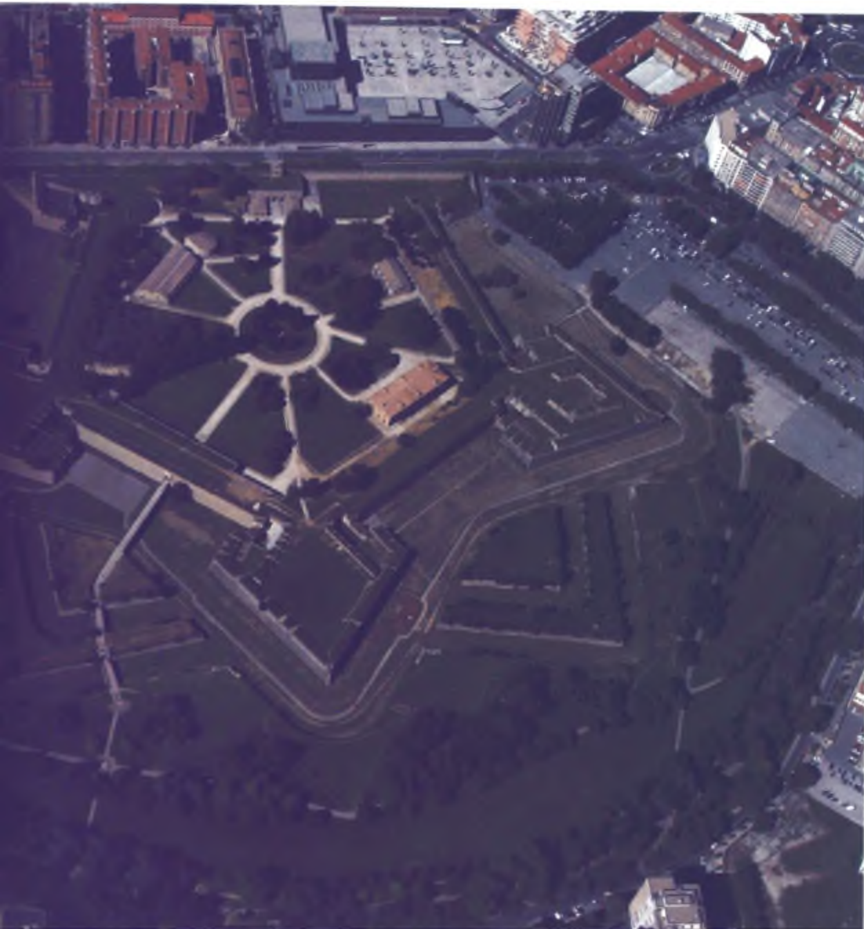
Vista aérea de la ciudadela, con las dos contraguarnidas añadidas en 1685 (Foto: Larrión y Pimouier)
