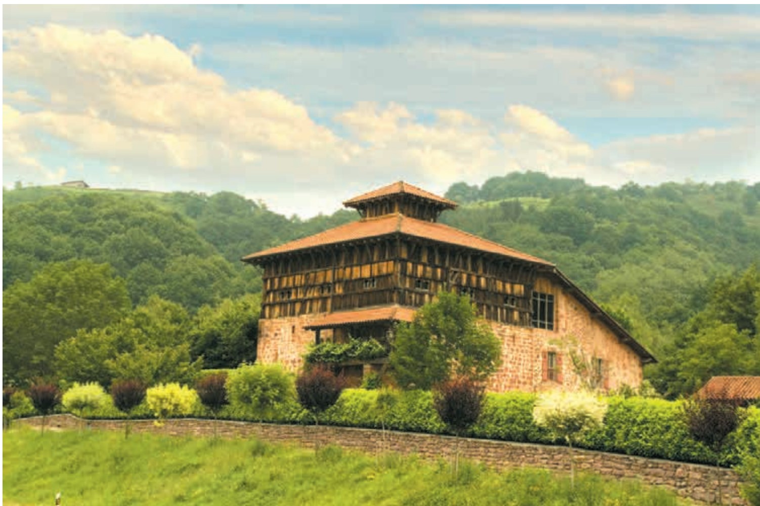
Palacio de Jaureguizar tras su restauración en 1989 (Foto: Larrión y Pimoulier)
