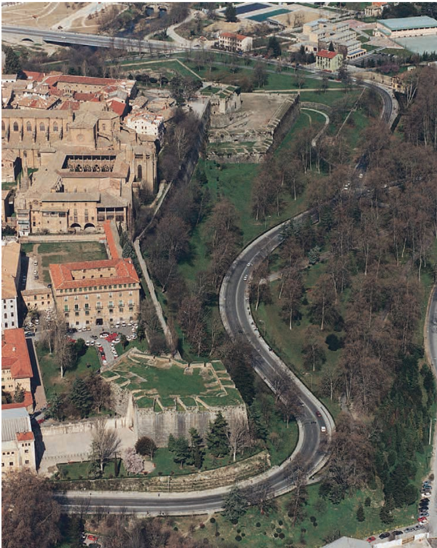
Baluartes de Labrit, ronda de la Barbazana y baluartes del Redín y de Guadalupe. (Foto: Larrión y Pimoulier)
