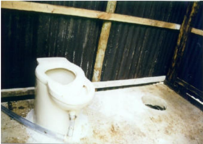
Se elige uno de los hoyos para colocar la taza separadora. Después se prepara la mezcla con poca carga de cemento para evitar que la taza pueda romperse al cambiarla al otro hoyo.
