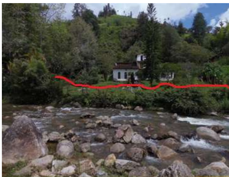
Foto 91. Zona de inundación en el Río Concepción. Punto 4. Obsérvese la gran cantidad de bloques de roca y las pequeñas áreas inundables aledañas.
